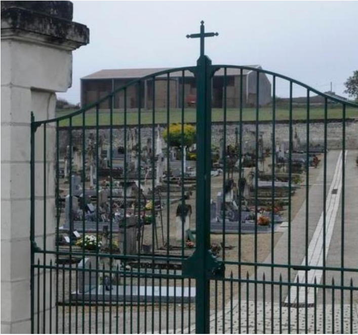
Le portail d'entrée a été installé au début des années 2000 pour remplacer l'ancien, trop vétuste. - (Photo Patrick Lavaud)
